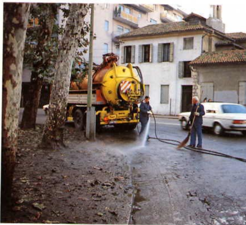
Il getto d'acqua ad alta pressione permette di eliminare il terriccio che ostruisce i pozzetti.
