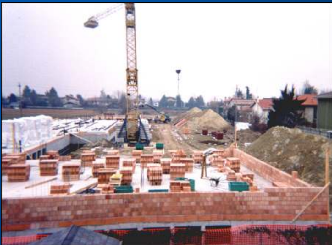
IL CANTIERE DEL DON VECCHI BIS
